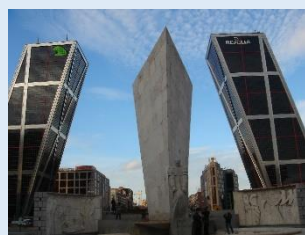
Kio Towers, Madrid (Spain)
